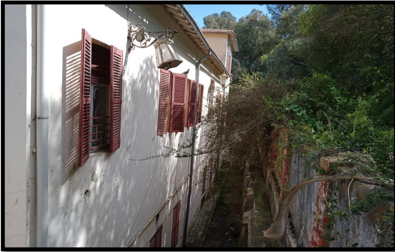
صورة 30: الواجهة الجنوبية للقصر
